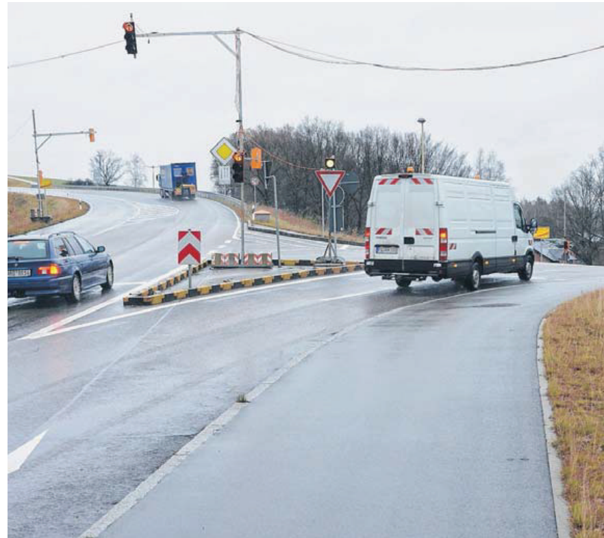
Der Verkehrsknoten in Kertzsch ist nach wie vor ein Provisorium.
