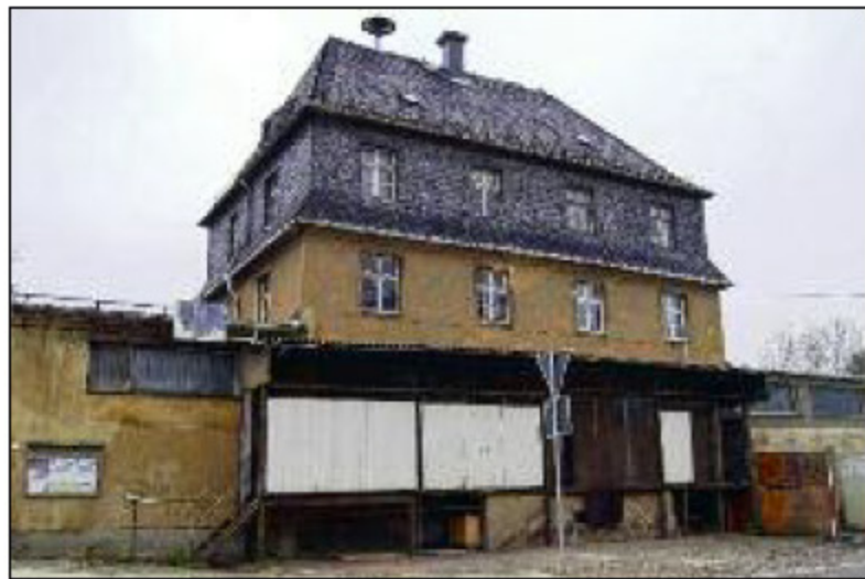
Das alte Konsumgebäude wird in diesem Jahr abgebrochen.
