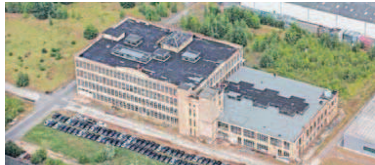
Der Horch-Hochbau im Zwickauer Stadtteil Pölbitz soll zur Landesausstellung 2018 der zentrale Ort der Veranstaltung sein.
