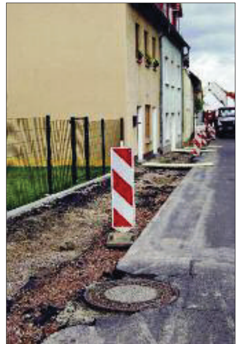
Ein Teilstück der Hoffnung wird mit einem Schutzstreifen versehen, um den Anliegern künftig mehr Sicherheit zu geben. Die Fa. STRATA Bau GmbH aus Meerane trug zu Baubeginn die Deckenschicht auf Wegbreite ab.
