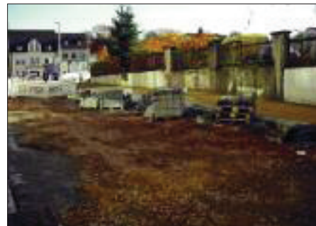
November: die Tiefbauarbeiten sind beendet...
