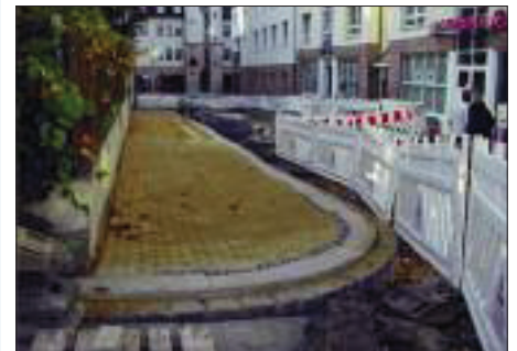
und die Pflasterung der Gehwege wird realisiert.
