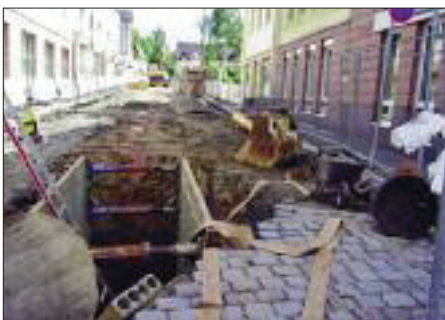
Kanalbauarbeiten im August...
