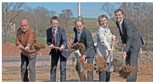
■ Jan Löffler (r.) beim Spatenstich im April 2013.
